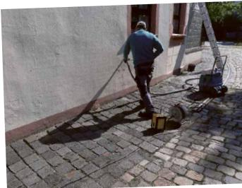
Beim Suchtberatungszentrum der AWO Bremerhaven wurde die Kerndämmung der Außenwände mit einer Übernahme von 50 % der Kosten unterstützt. Durch die Baumaßnahme kann der Heizenergiebedarf künftig um rund 20 % gesenkt werden.
